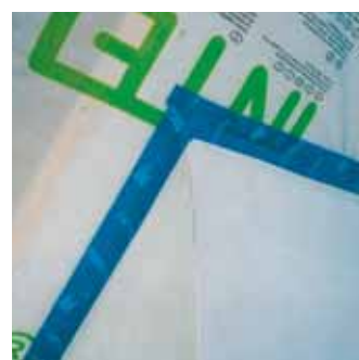
Raccord du freine-vapeur à une cheminée en éléments de montage lisse, non poreuse et non friable avec pro clima TESCON PROFIL.
