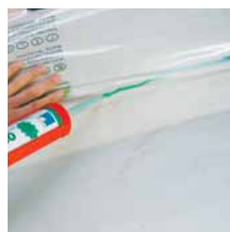
Raccord du freine-vapeur à une dalle en console avec pro clima ORCON F.
